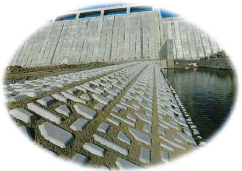
覆土状況写真
