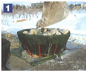
1 製作用型枠内にE-ユニットを設置し、中詰め材を投入します。
