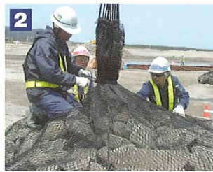
2 中詰め材投入後、口縛りロープを結束します。
