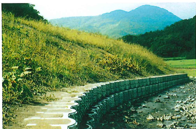
平成12年5月 施工完了直後
