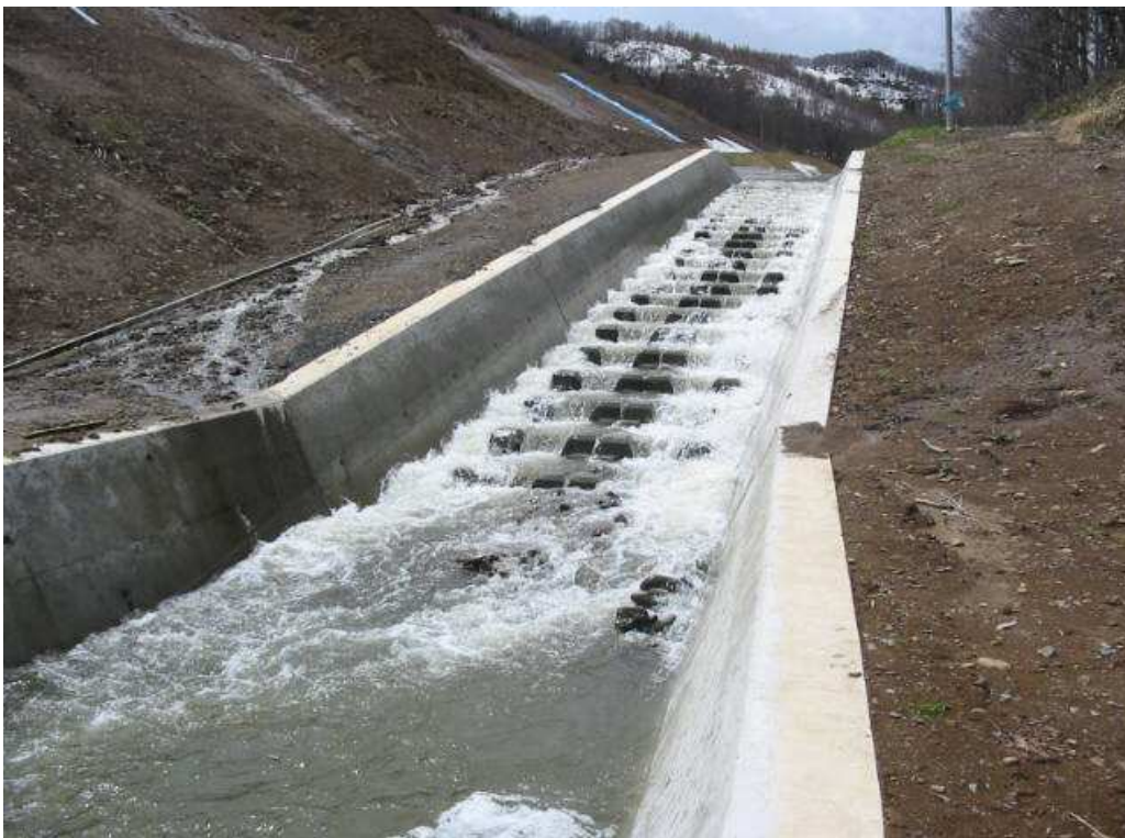
西岡ダム付け替え道路工事(旭川土現)
