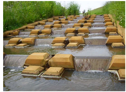
準用河川改修費補助下福移川改修工事(札幌市)
